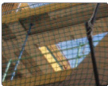
RED SEGURIDAD EN1263 Sistema U+cuerda perimetral. Redes de protección en largos variables, adaptables al proyecto. Polipropileno alta tenacidad, M100, Opcional: red mosquitera/anti-cascotes
